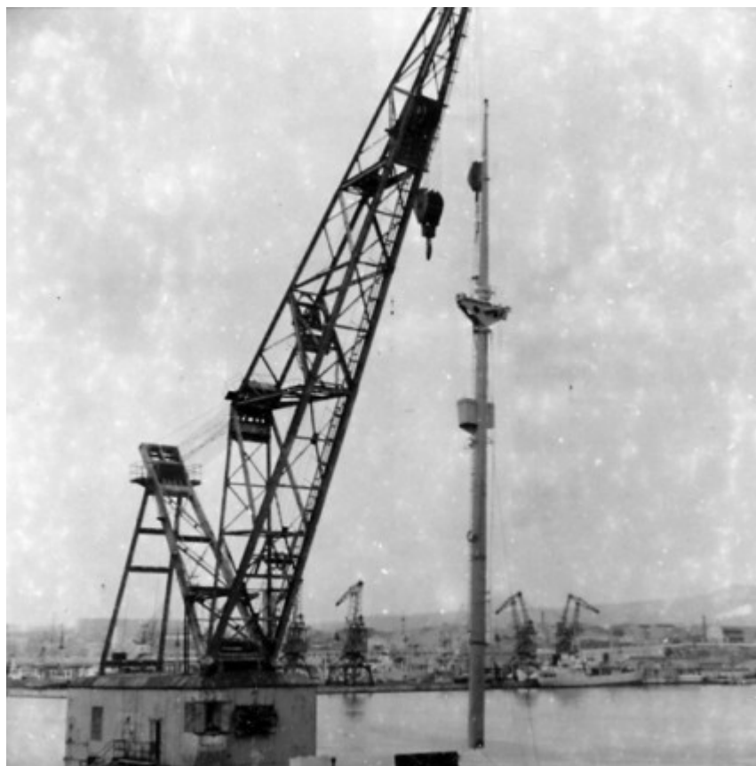
Il nuovo albero viene piazzato tramite una gru galleggiante
